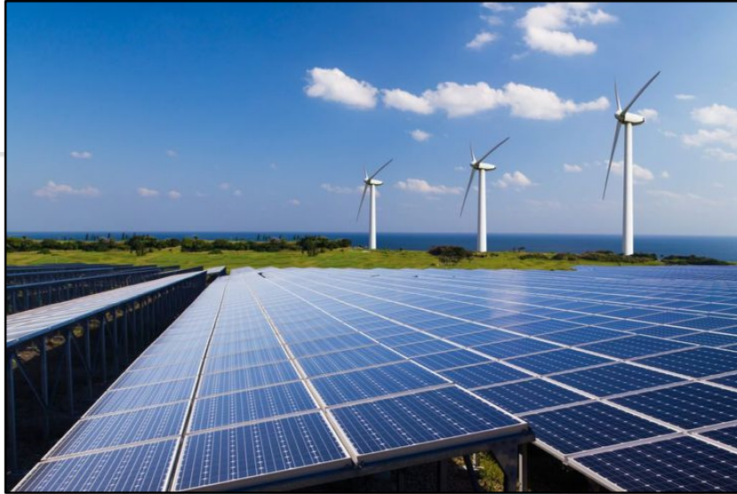
Gambar 2.3 Pembangkit Listrik Tenaga Surya (Sumber: ICAsolar, 2023)
