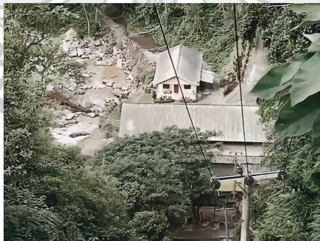
Gambar 3. 2 Power House Tampak dari Atas
