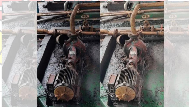
Gambar 2.10 Pompa Bahan Bakar Sumber : Foto ULPLTD Hative Kecil
