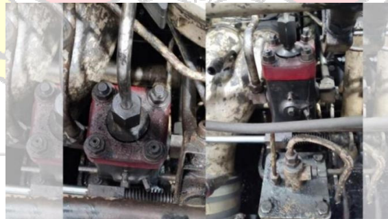
Gambar 2.12 Pompa Injeksi Sumber : Foto ULPLTD Hative Kecil
