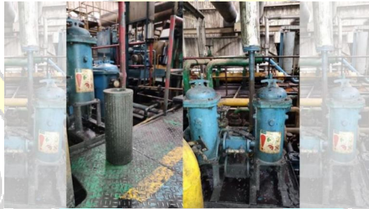
Gambar 2.11 Saringan Bahan Bakar Sumber : Foto ULPLTD Hative Kecil
