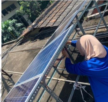
Proses Pemasangan Panel sebagai Sumber Energi DC
