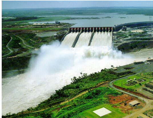
Gambar 2. 1 Pembangkit Listrik Tenaga Air (Sumber: dunia-energi.com)
