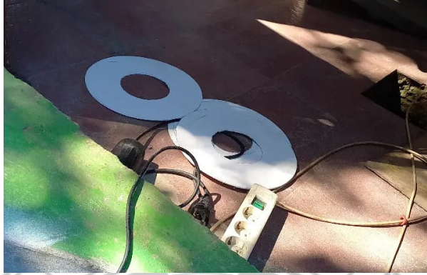
Gambar 1 Pembuatan Ulir Turbin
