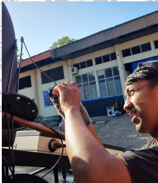
Lampiran 9 Pemasangan Sensor
