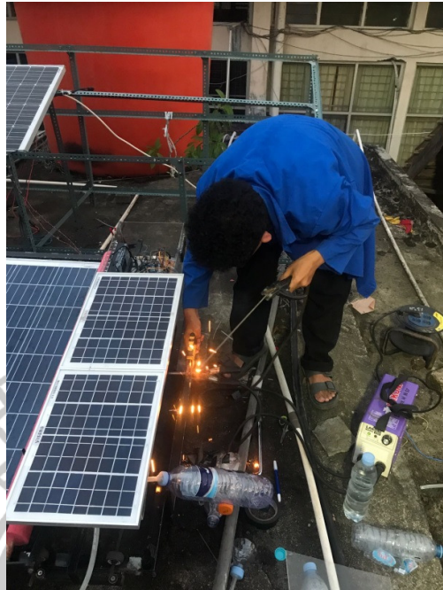
Gambar 15 Pengelasanudukan bak air
