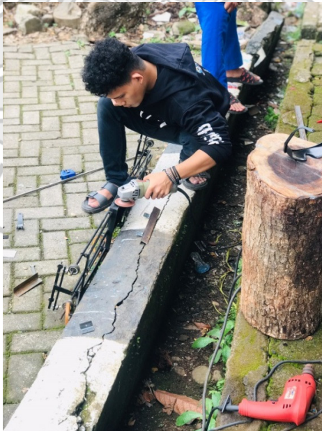
Gambar 10 Memperhalus hasil pengelasan
