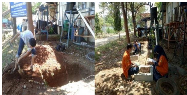
Gambar 9. Proses Pengeboran Tanah, Penanaman Elektroda Plat, Proses Pengambilan Data, dan Proses Pengujian
