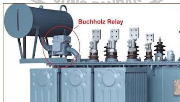
Gambar 2.17 Penempatan Rele Bucholz
