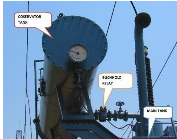
Gambar 2.13 Penempatan Relé (Sumber : Arief Goeritno dan Syofyan Rasiman, 2019)
