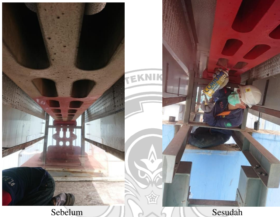
Gambar 4.18 Sebelum dan Sesudah Perbaikan Busbar 11,5 kV (Sumber: ULPLTG Tello, 2021)
