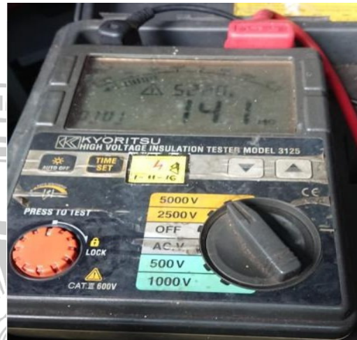
Gambar 4.13 Pengukuran phase S 11,5 kV
