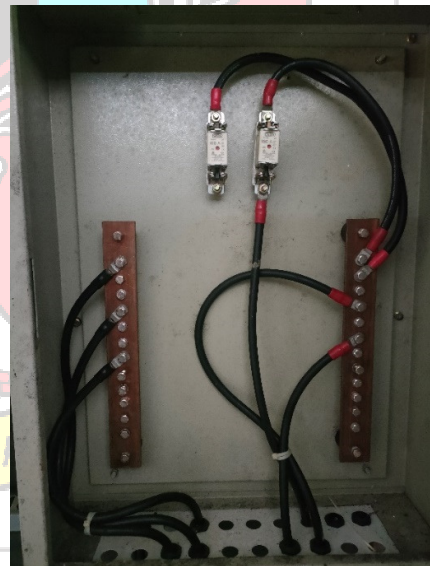
f. Tampilan Dalam Array Junction Box dan Dalam Battery Connection Box
