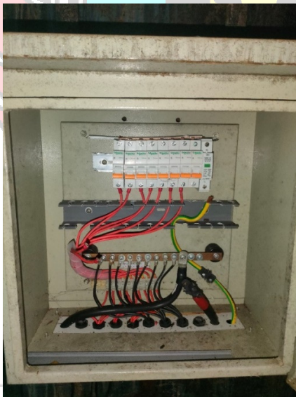
f. Tampilan Dalam Array Junction Box dan Dalam Battery Connection Box
