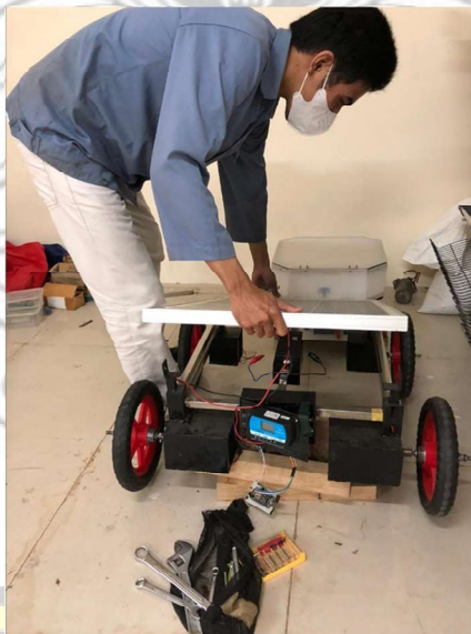
Pemasangan Panel Surya
