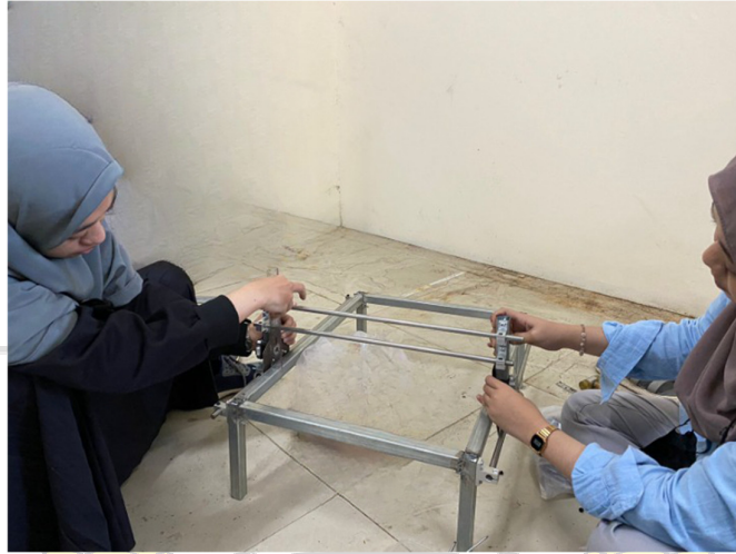
Gambar 23 Pembuatan rangka robot
