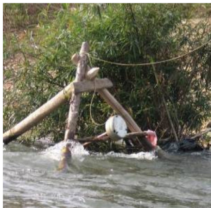
Gambar 6. Pemasangan picohydro langsung di aliran sungai dengan menggunakan penopang kayu.
