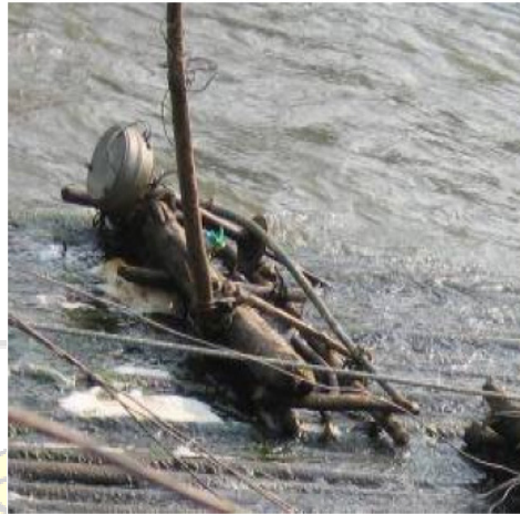
Gambar 7. Pemasangan picohydro langsung di aliran sungai dengan menggunakan rakit.
