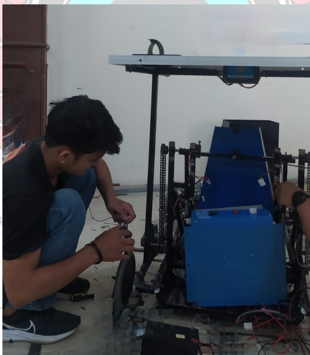
Proses Pemasangan Rangkain Elektronik Alat
