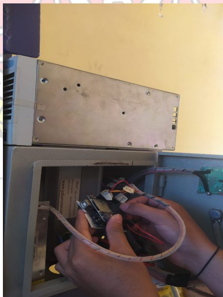
Pemasangan Arduino Pada Panel Box
