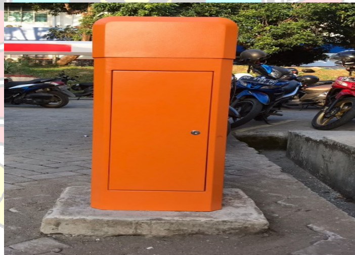
Gambar 4. 1 Hasil Pembuatan Dudukan Mesin Barrier Gate
