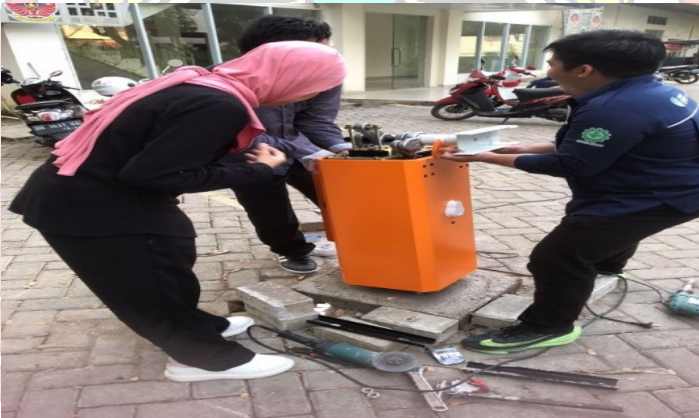
Proses Penempatan Dudukan Mesin Barrier Gate
