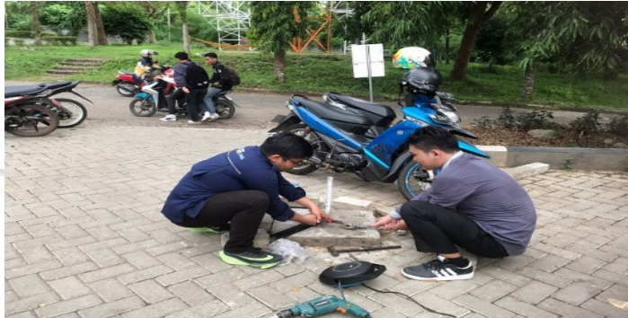
Proses Pembuatan Dudukan Mesin Barrier Gate
