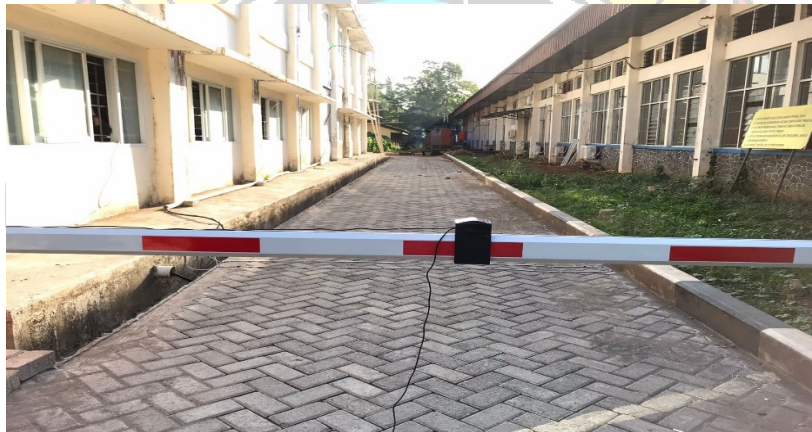
Hasil Pemasangan Kamera pada Palang
