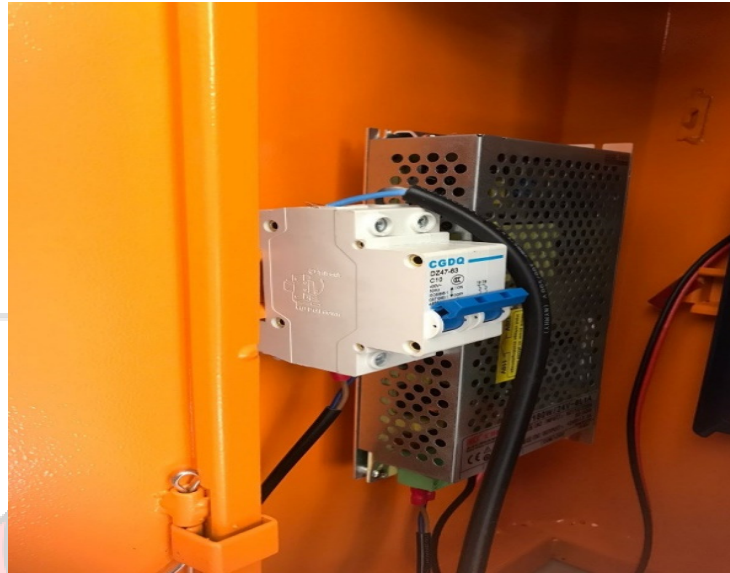
Gambar 4. 4 Hasil Pemasangan MCB pada Mesin Barrier Gate
