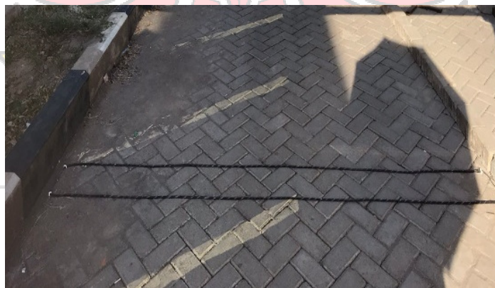
Gambar 4. 5 Hasil Pemasangan Sensor VLD
