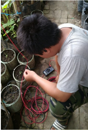
Pemasangan Kabel pada Panel Surya
