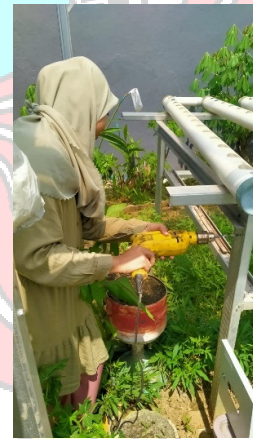
Pembuatan Lubang Baut pada rangka Hidroponik untuk Panel Box
