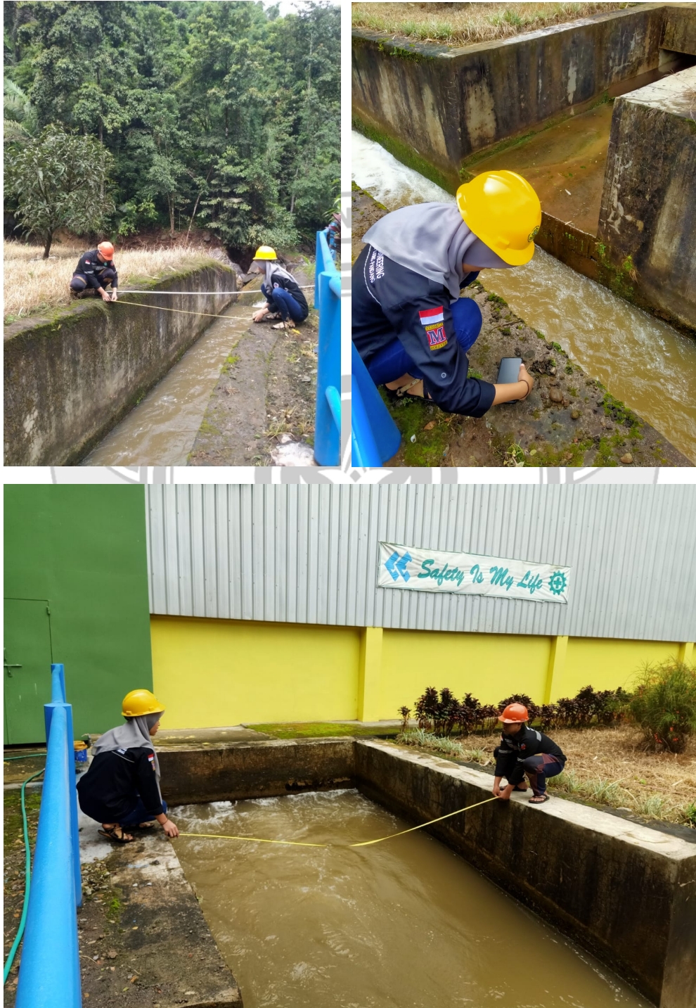
Lampiran 1. Pengukuran lebar dan elevasi pada saluran tailrace
