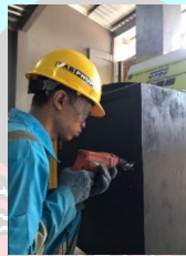
Gambar 3.11 Pemasangan grendel
