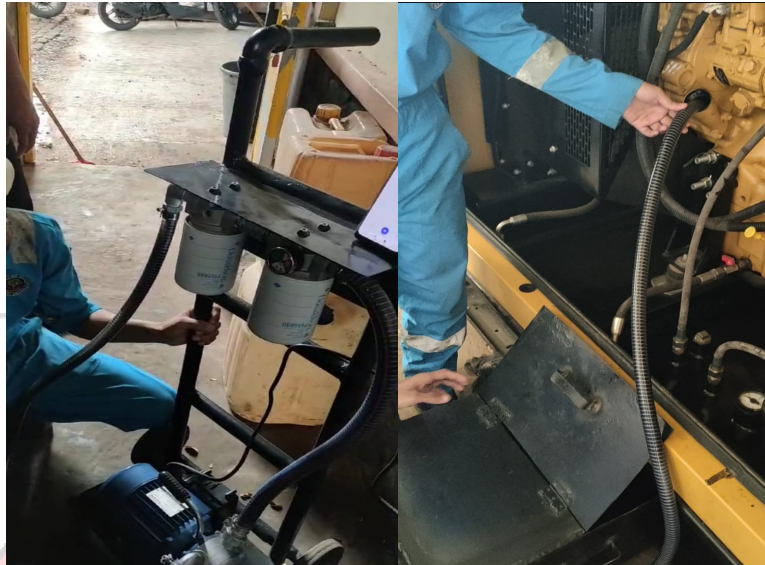
Gambar 4.2 Proses Pengujian Alat Pada Genset
