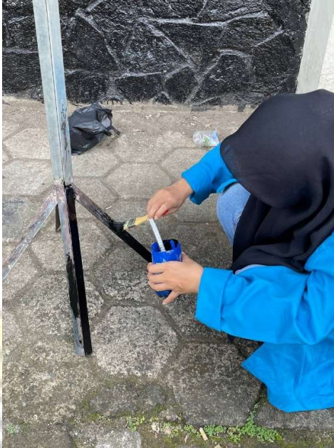
Pengecatan Besi Rangka Pane
