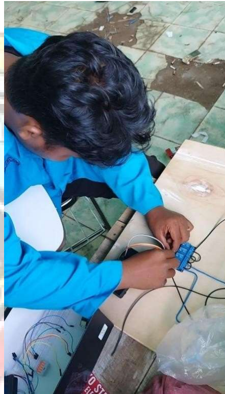
Proses perakitan rangkaian kontrol
