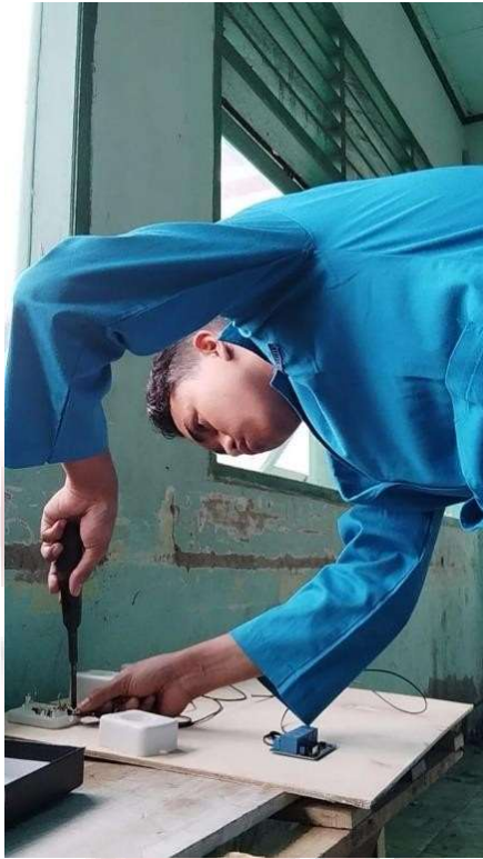
Proses pemasangan instalasi
