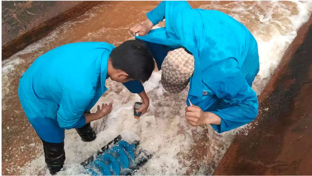
Gambar 14 Pengujian putaran Turbin yang terkopel dengan Generator
