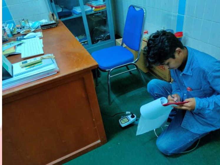
Pengukuran dan pengambilan data peralatan listrik ruangan
