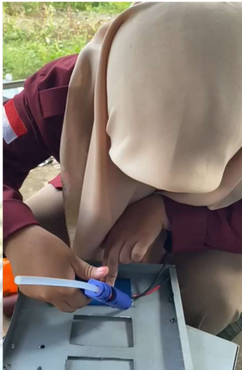
Pemasangan Wattmeter pada box panel
