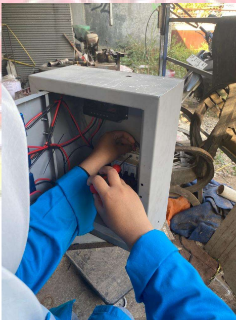
Pemasangan instalasi listrik
