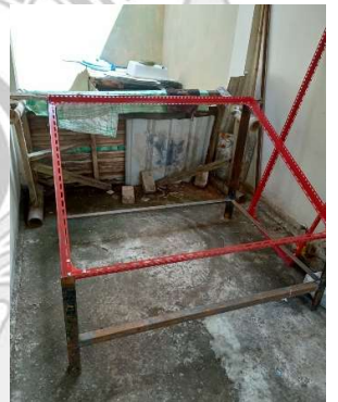
Perakitan rangka panel
