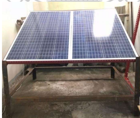
Pemasangan panel pada rangka
