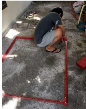
Pemasangan baut rangka panel
