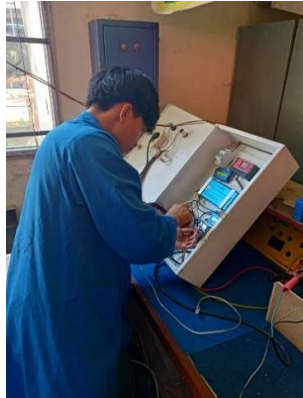
Perakitan sistem kontrol
