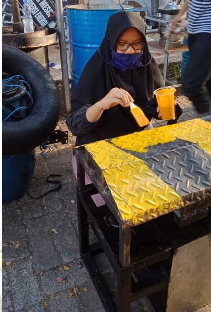
Gambar 6. Pengecatan Plat Besi pada Speed Bump
