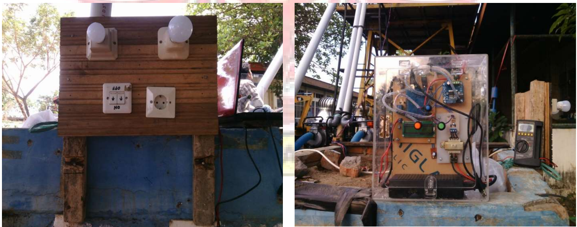
Proses pemasangan sistem kontrol
