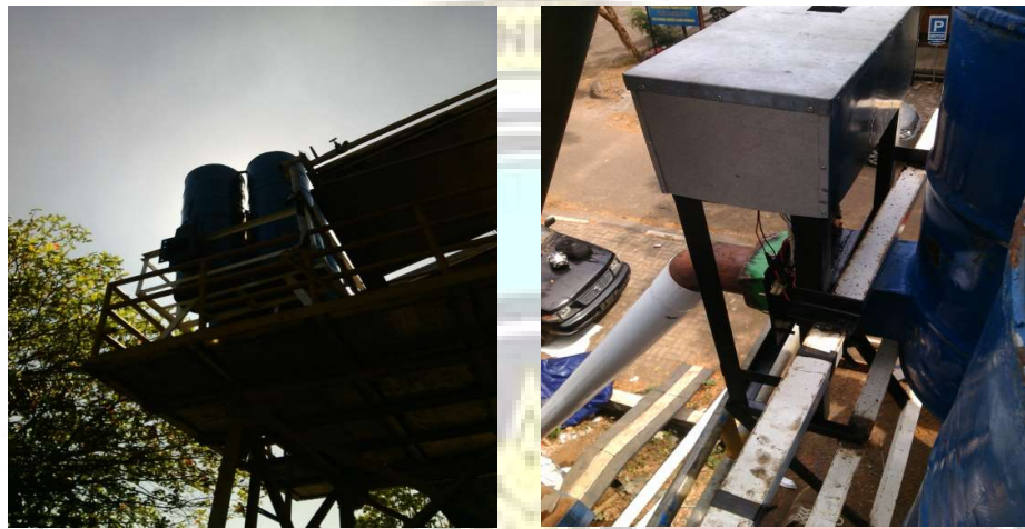
Proses pemasangan sistem mekanik
