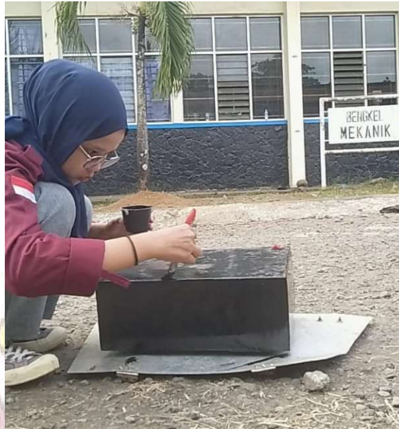
Pengecatan Panel Sistem Kontrol
