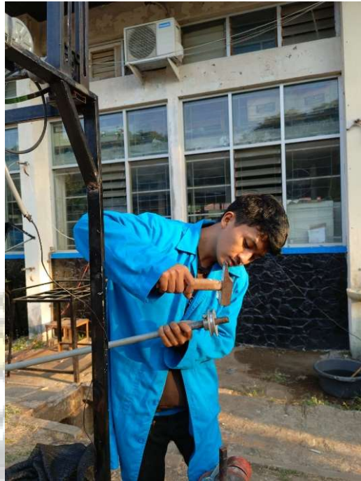
Pemasangan Pulley pada Poros Atap Otomatis
