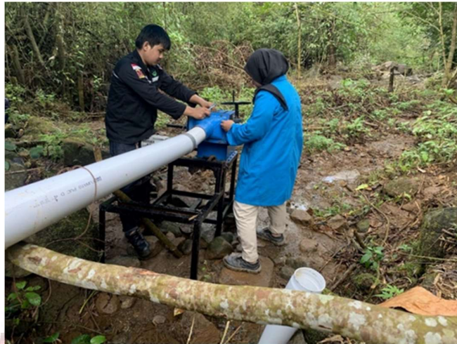
Gambar 9. Proses Pemasangan PLTMH
