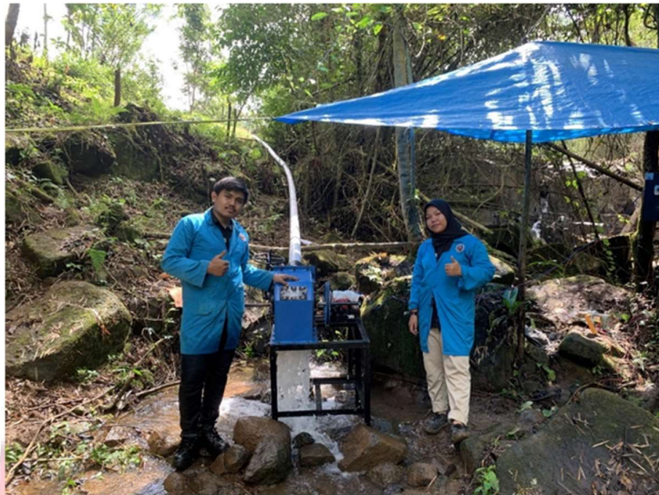
Gambar 13. Penyelesaian Pengujian PLTMH
