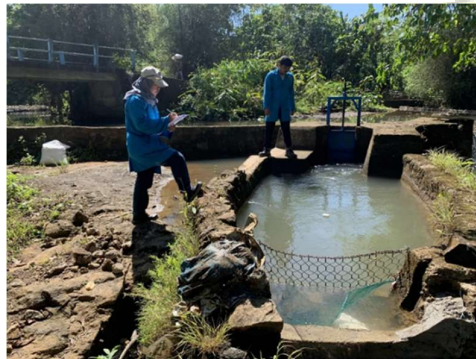
Lokasi Konstruksi Bendungan sumber: Dokumen Pribadi
