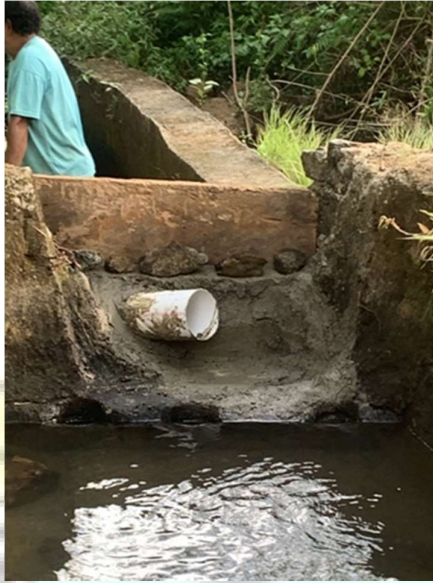
Gambar 7. Proses Pemasangan Pipa Penstock
