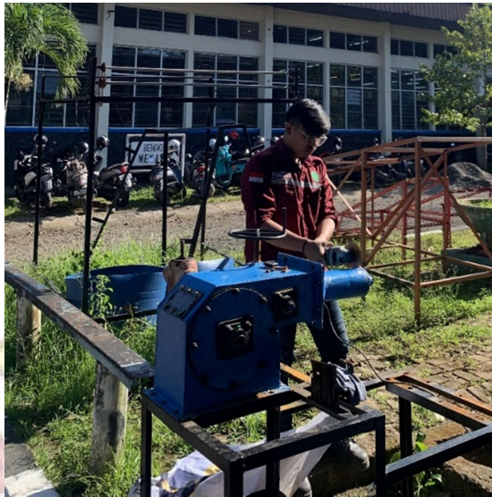
Gambar 1. Proses Konstruksi Penstock
