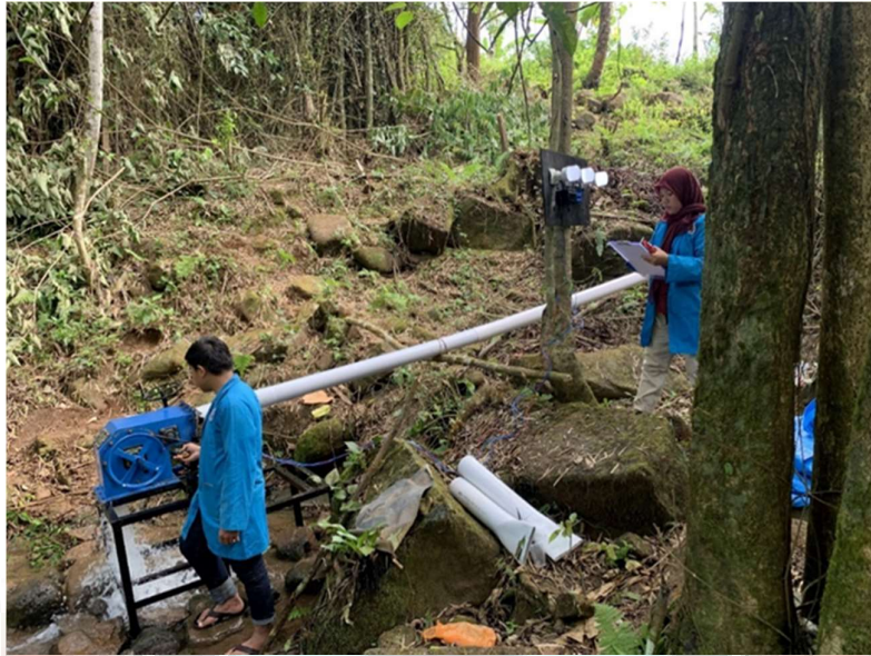
Gambar 11. Proses Pengambilan Data Berbeban Tegangan DC
