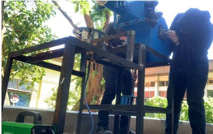
Gambar 3. Proses Pemasangan Turbin
