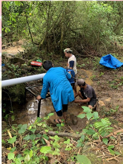
Gambar 8. Proses Pemasangan Rangka Dudukan PLTMH
