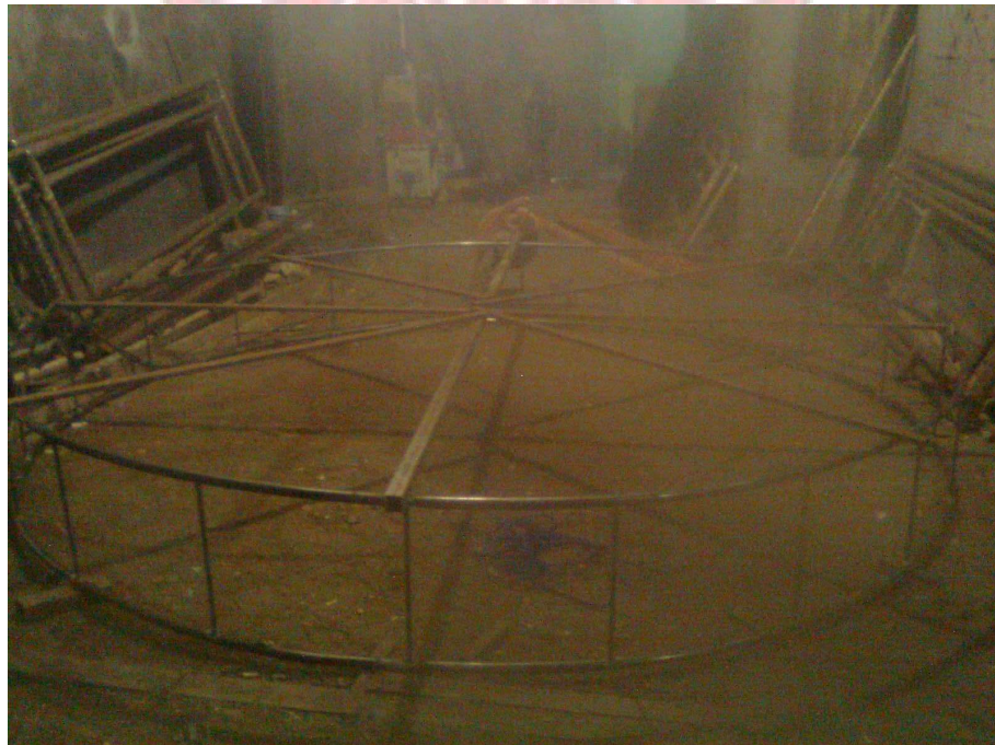
Gambar 4.6 Foto proses pemasangan jari-jari kincir
