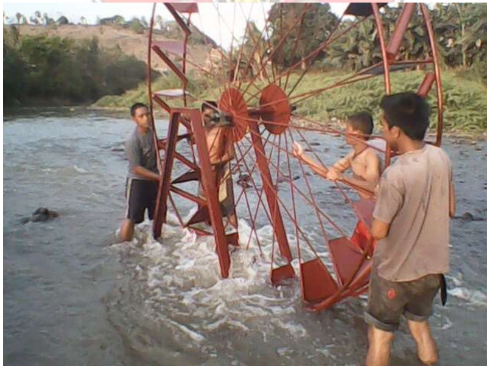
Gambar 4.10 Foto proses pemasangan kincir air
