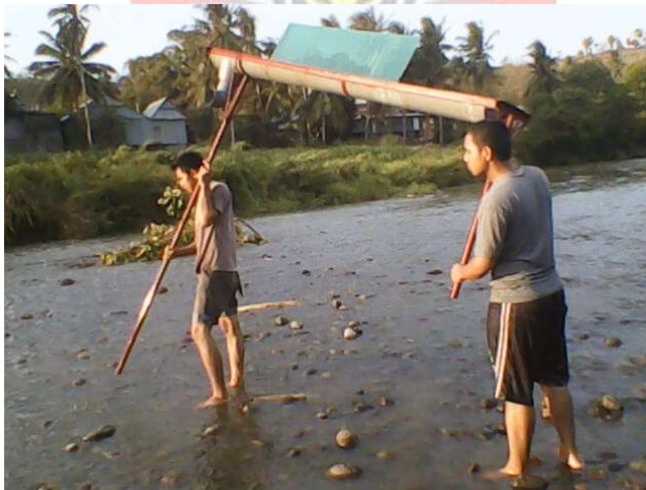
Gambar 4.12 Foto proses pengangkatan talang air
