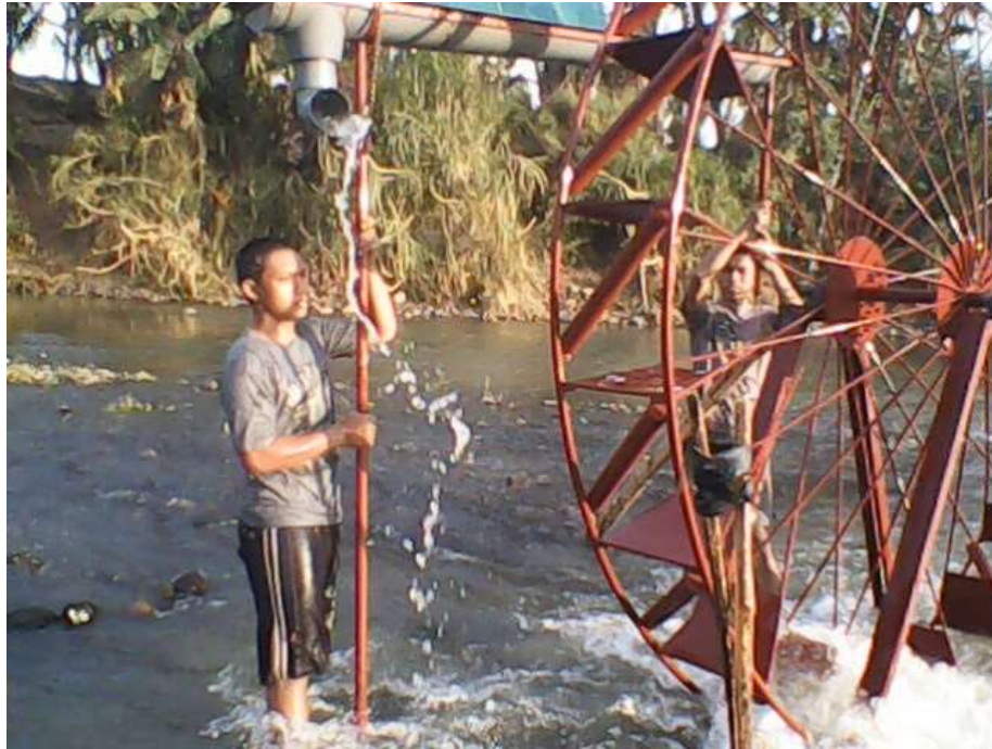
Gambar 4.11 Foto proses pemasangan talang air
