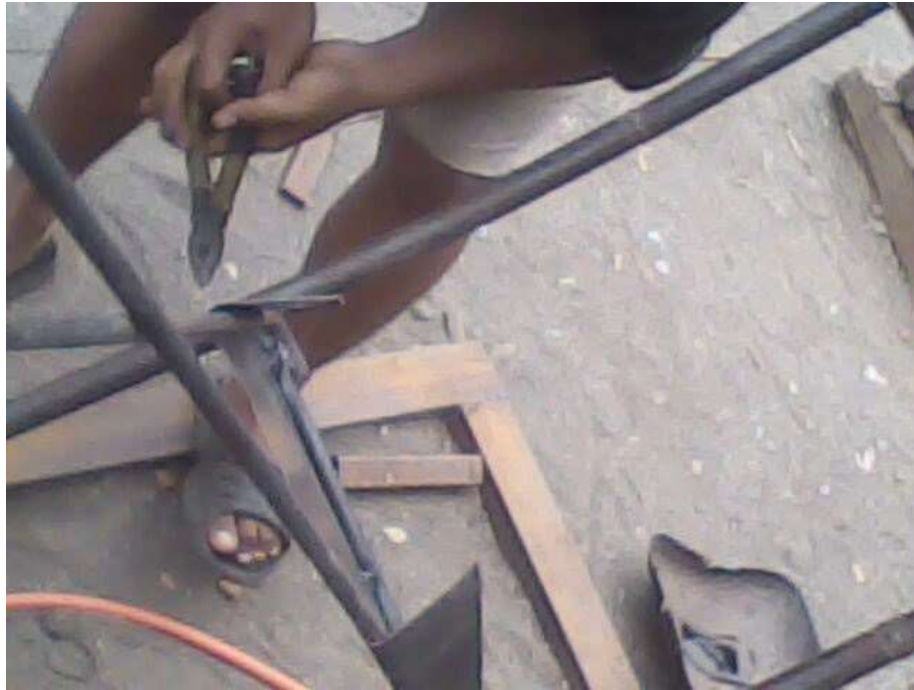
Gambar 4.7 Foto proses pemasangan sudu-sudu kincir
