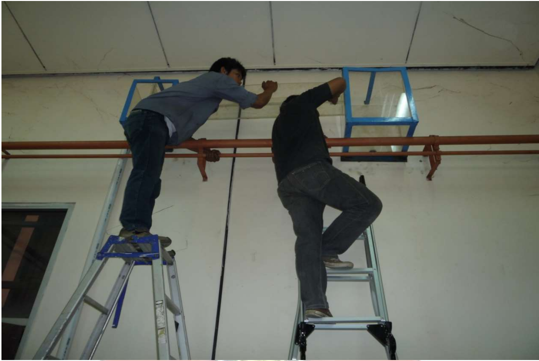
Gambar 4. Pemasangan saluran pembawa.
