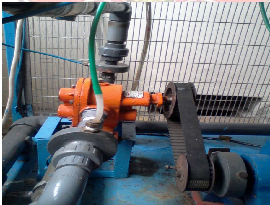
Gambar 2. Pompa roda gigi yang baru yang sudah terpasang.
