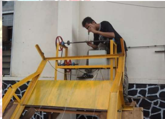
Proses Pemasangan Tali Penarik
