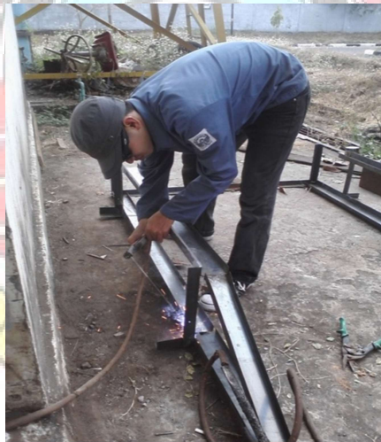
Pengelasan Rangka Utama
