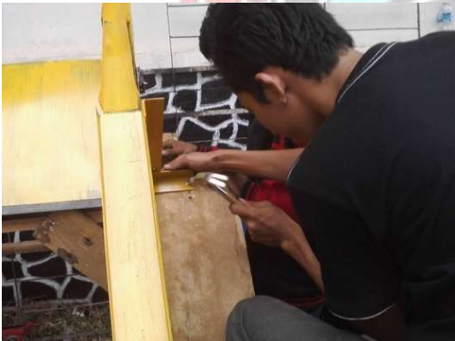
Proses Pemasangan pada Bidang
