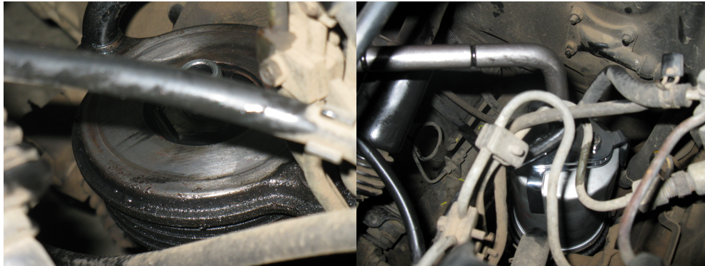
Gambar pemasangan saringan oli
