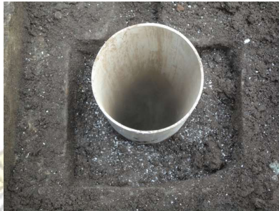
Gambar 4. Pemasangan pipa PVC
