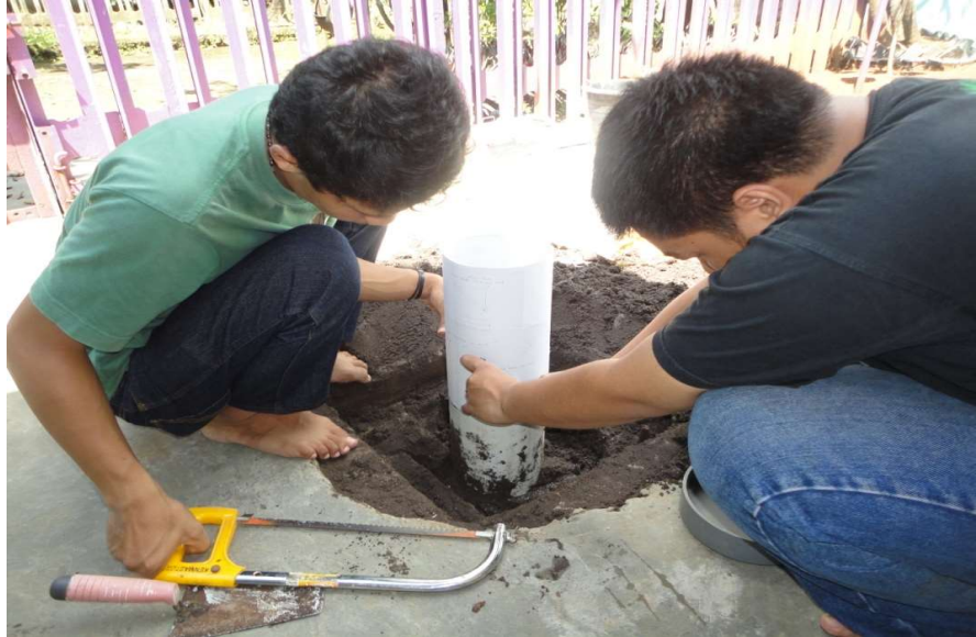
Gambar 1. Pengukuran Pipa PVC
