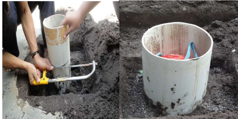
Gambar 6. Pemotongan pipa PVC
