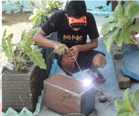
Gambar 12. Pengelasan tangki oli
