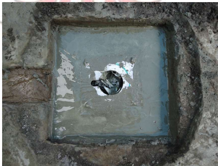
Gambar 5. Pengecoran tempat tabung hidrolik.
