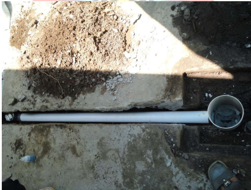
Gambar 6. Pemasangan Pipa pada Jalur Pipa Hidrolik
