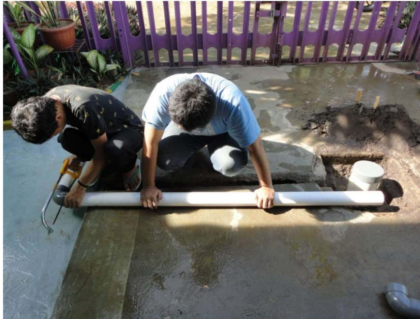
Gambar 5. Pembuatan Jalur Pipa Hidrolik
