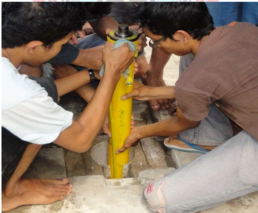
Gambar 14. Penurunan Tabung Hidrolik
