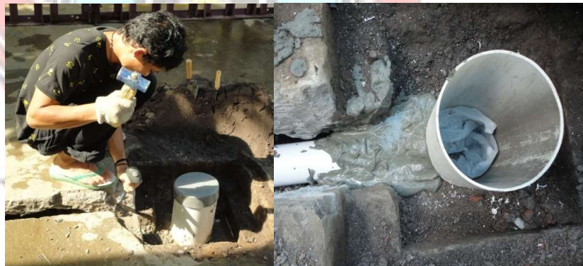
Gambar 7. Pembuatan jalur pipa hidrolik
