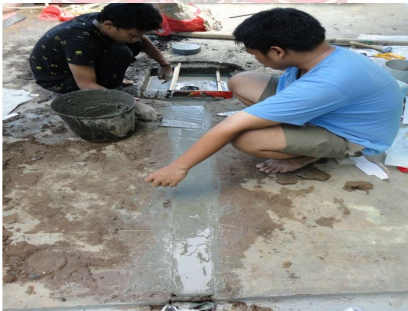
Gambar 10. Pengecoran Jalur Pipa Hidrolik
