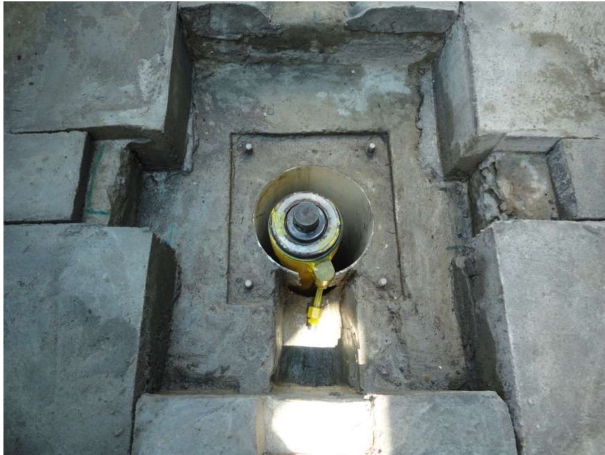
Gambar 15. Penyetetelan Posisi Tabung Hidrolis
