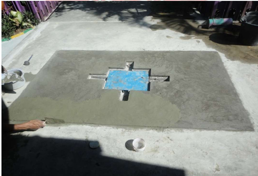
Gambar 24. Area Kerja Pengecoran
