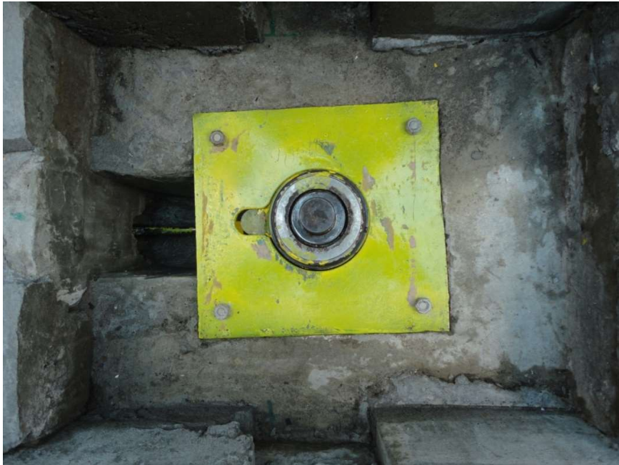
Gambar 17. Pemasangan Plat Pemegang Tabung
