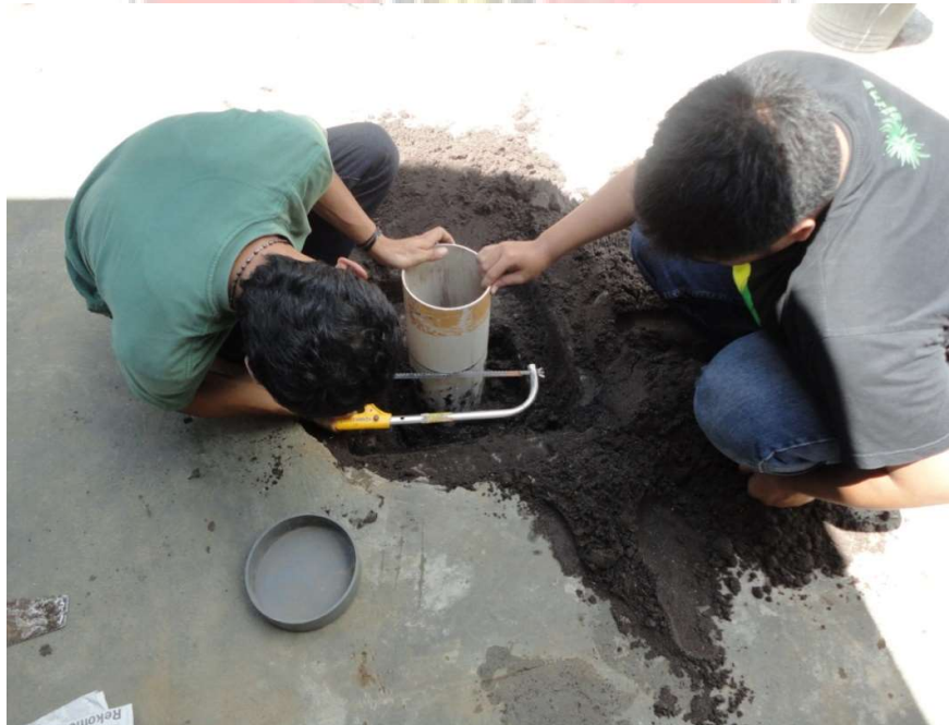
Gambar 2. Pemotongan Pipa PVC
