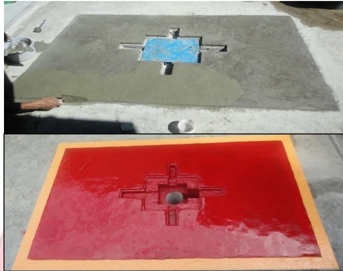
Gambar 10. Area kerja alat angkat sepeda motor sebelum dan sesudah proses finising.
