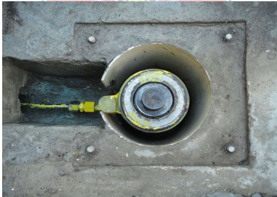
Gambar 16. Pemasangan Pipa Hidrolis dengan Tabung
