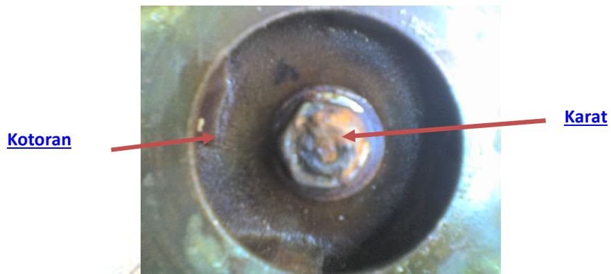
Gambar 3.10 Impeler pompa sentrifugal.
