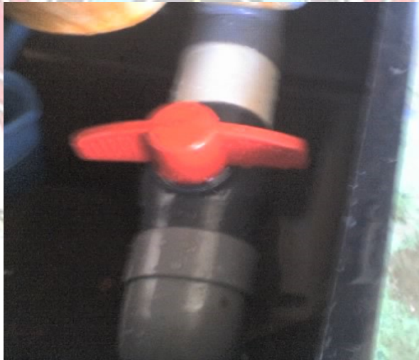
Gambar 3.25 a. Sambungan bak volumetrik dengan stop kran, b. Stop kran.
