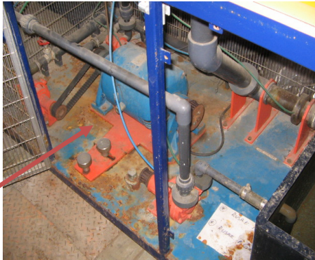
Gambar 3.17 a) Landasan multi pump secara keseluruhan. b) Landasan motor penggerak.
