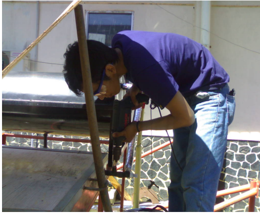
Foto 16. Pemasangan Termometer Fluida Input
