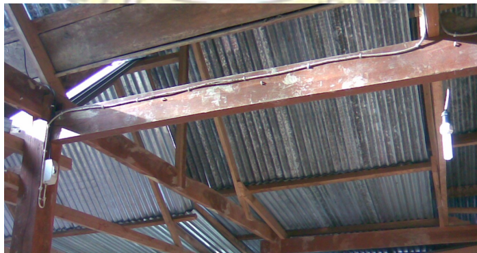
Gambar 19. Instalasi konsumen pada tiap rumah di desa Bungin Kab. Enrekang.
