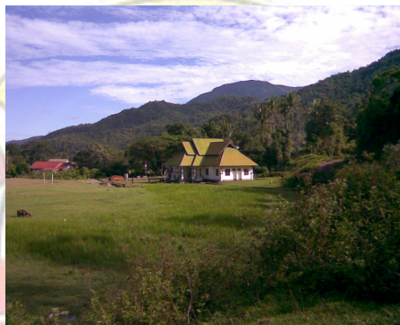
Gambar 70. Kantor Kecamatan Bungin Kab.Enrekang
