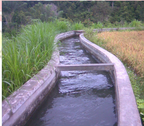
Gambar 3. Saluran Pembawa ke bak penenang PLTMH Bungin Kab. Enrekang
