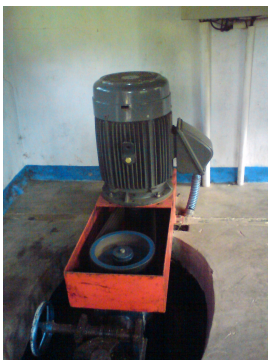
Gambar 48. Generator unit pembangkit I tampak dari depan
