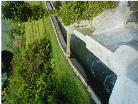
Gambar 60. Intake saluran pembawa PLTMH di Desa Bungin Kab.Enrekang
