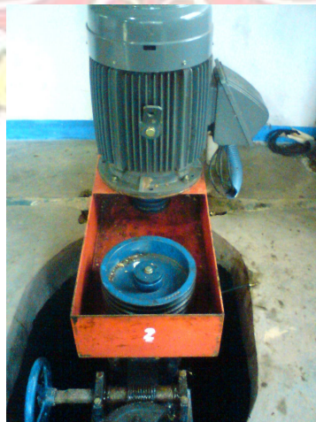
Gambar 74. Kondisi Pembangkit Unit 2 dalam proses perbaikan
