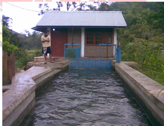
Gambar 4. Bak Penenang PLTMH Bungin Kab. Enrekang
