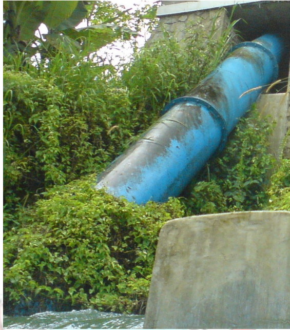
Gambar 24. Pipa pelepas air PLTMH Bungin Kab. Enrekang
