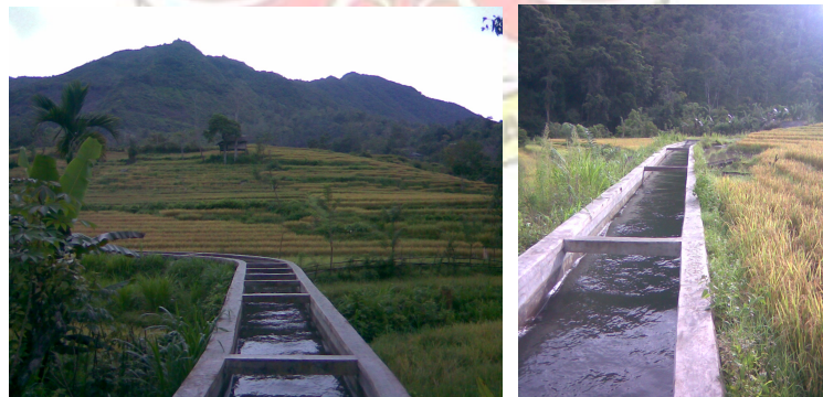
Gambar 65. Kondisi saluran pembawa PLTMH di Desa Bungin Kab.Enrekang
