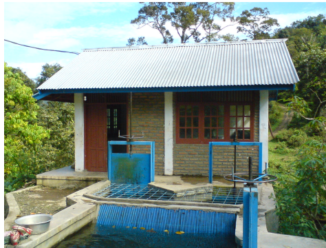
Gambar 42. Power House PLTMH Bungin Kab. Enrekang Tampak Depan
