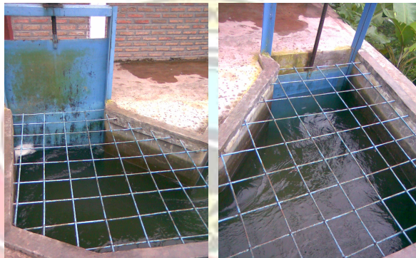
Gambar 64. Pintu air turbin beserta saringan
