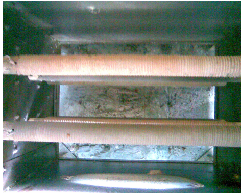
Gambar 26. Batang pemanas PLTMH Bungin Kab. Enrekang
