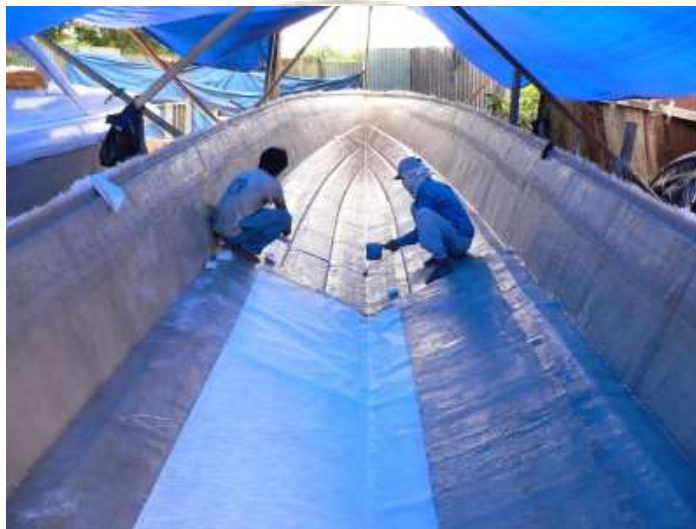
Gambar 10. Pembuatan perahu berbahan fiberglass
