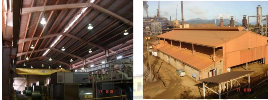
Gambar 2.8 bangunan MBDG pada PT.INCO
