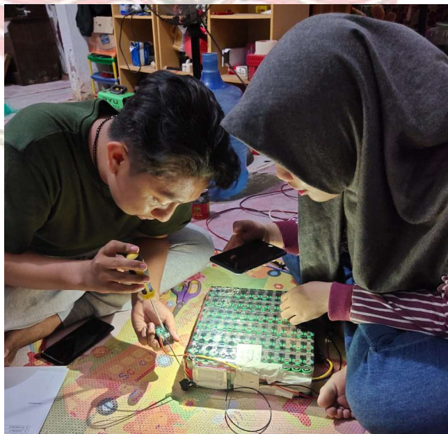
Lampiran 2 Pemasangan Display Ammeter
