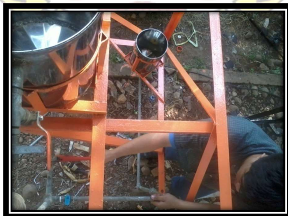
Lampiran A-6. Gambar proses pengerjaan instalasi pemipaan
