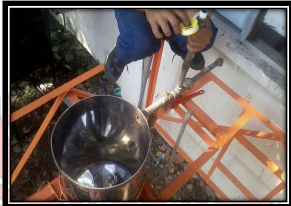
Lampiran A-5. Gambar proses perakitan instalasi pemipaan
