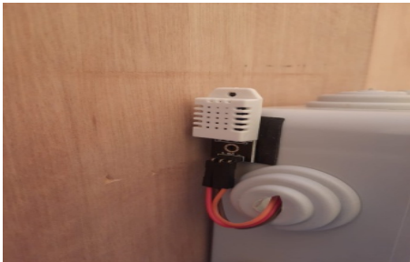
Pemasangan Sensor DHT22
