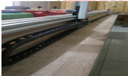
Pemasangan Drag Chain
