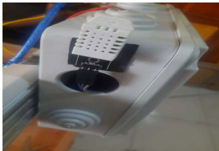
Pemasangan Sensor DHT22
