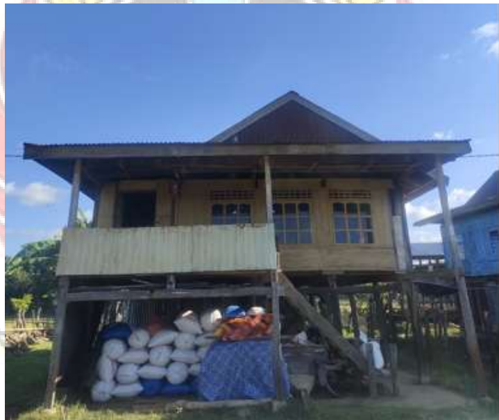
Gambar 4 1 Bangunan rumah daerah terpencil
