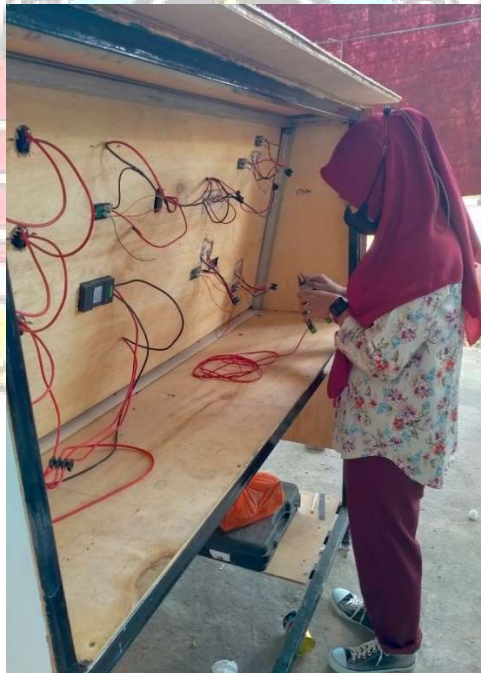
Proses Pemasangan Instalasi Rangkaian Listrik Modul Praktikum PLTS
