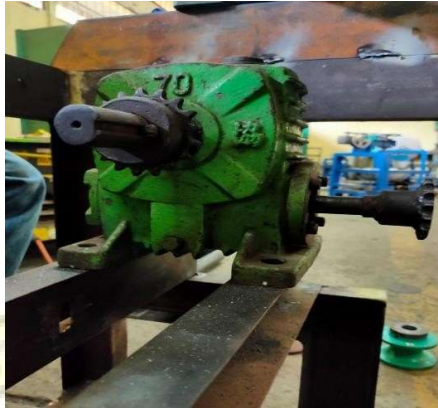
Gambar 3.8. Pemasangan Reducer Dan Motor
