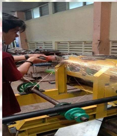
Gambar 4.10. Perbaikan pada roller penekan.
