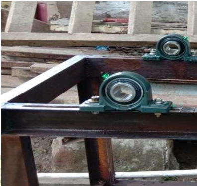
Gambar 3.3. Pemasangan Pillow Block UCP 208
