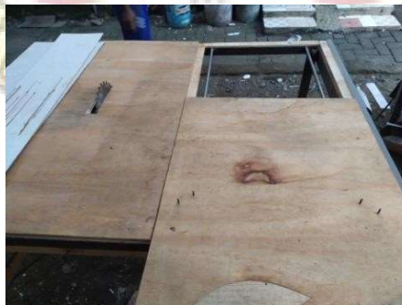
Gambar 3.5 Pemasangan Meja Tetap
