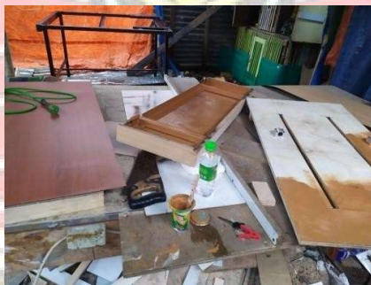
Pengecatan dan pemasangan high preassure laminate (hpl) pada part berbahan plywood
