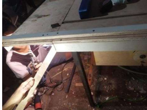
Gambar 3.6 Pemasangan Meja Ekstensi
