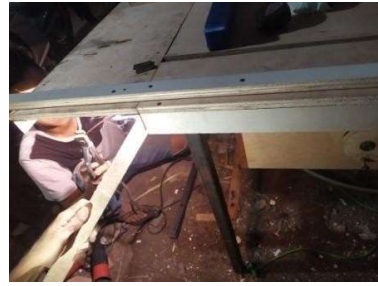
Pemasangan meja ekstensi dengan mekanisme engsel menggunakan las
