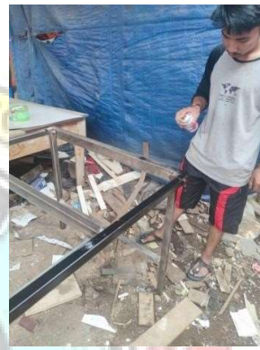
Pengecatan rangka
