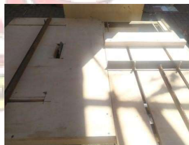
Pemasangan stopper dan adjustable jig
