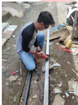
Pemotongan besi hollow untuk rangka
