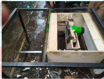
Gambar 3.4 Pemasangan Kotak Mesin
