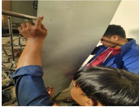
Gambar 4.29 Pemasangan Plat Seng Pada Rangka Bodi
